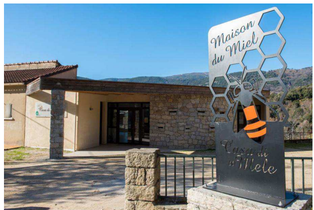
Figure 10 : Maison du miel de Murzo (PNRC).
