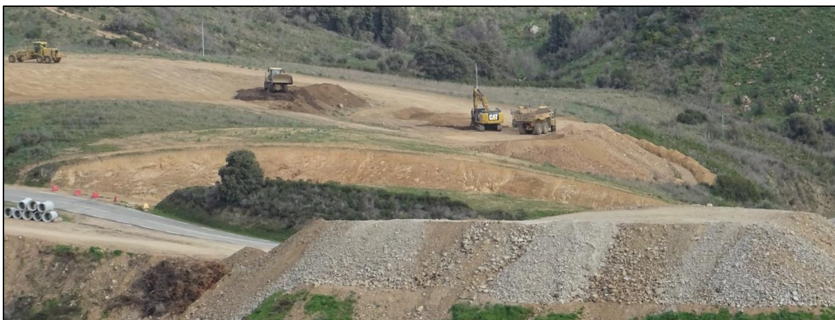
Figure 7 : Zone de travaux d'aménagements routiers.
